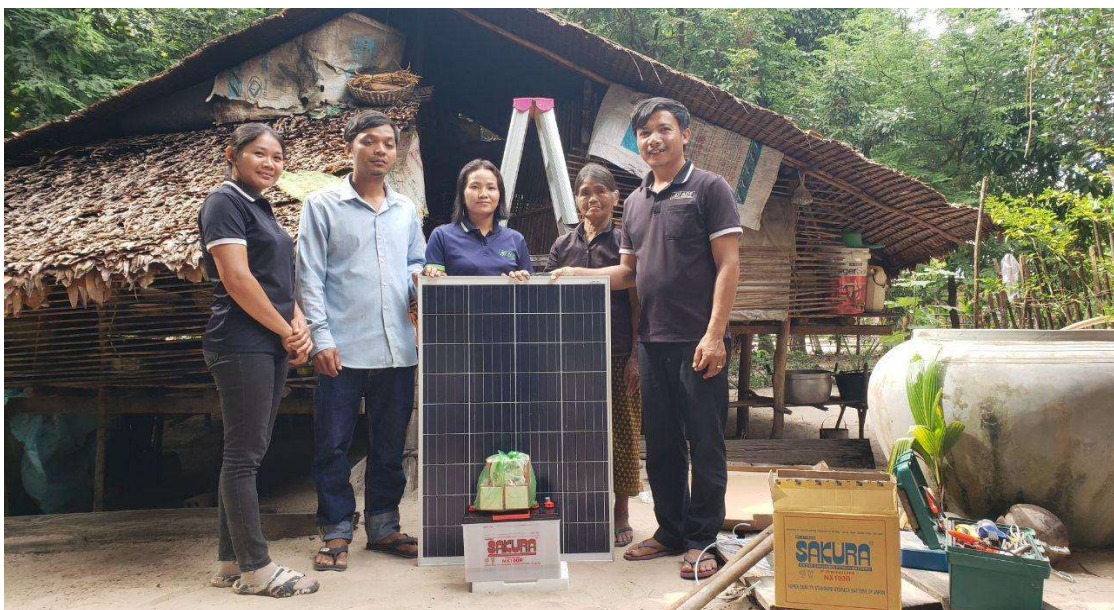
Installation d'un panneau solaire au mont Kulen
